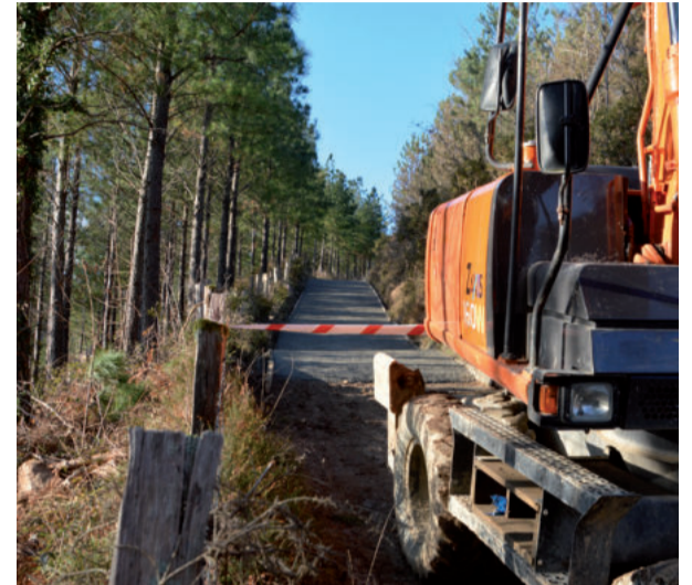
Idoia aldera iristeko pistaren gainean porlana bota dute zatirik arriskutsuean. Ehun metro inguruko luzera asfaltatzen ari dira.
