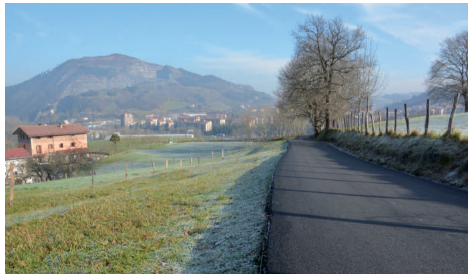
Bazkardo baserritik Garate aldera doan bidegurutzearino eta handik Sorabilla-Errotgaineraino doan bidea asfaltatu dute. Mendiluze baserriara doan bide zatia hurrengo egunetan asfaltatuko dute.
