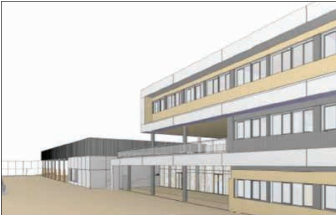
"Eraikin luze bat proiektatu da, ipar-ekialdetik hego-mendebalderako norabidean –lursailaren beraren konfigurazioari jarraiki– eta hiru solairu izango ditu: erdisotoko solairua, beheko solairua eta lehen solairua. Behar izanez gero, etorkizunean ikastetxea gorantz haztea (beste solairu bat gehituta) ahalbidetuko duten zimendu eta zutabeetan sostengatuko da", dio oharrak. IREKIA
