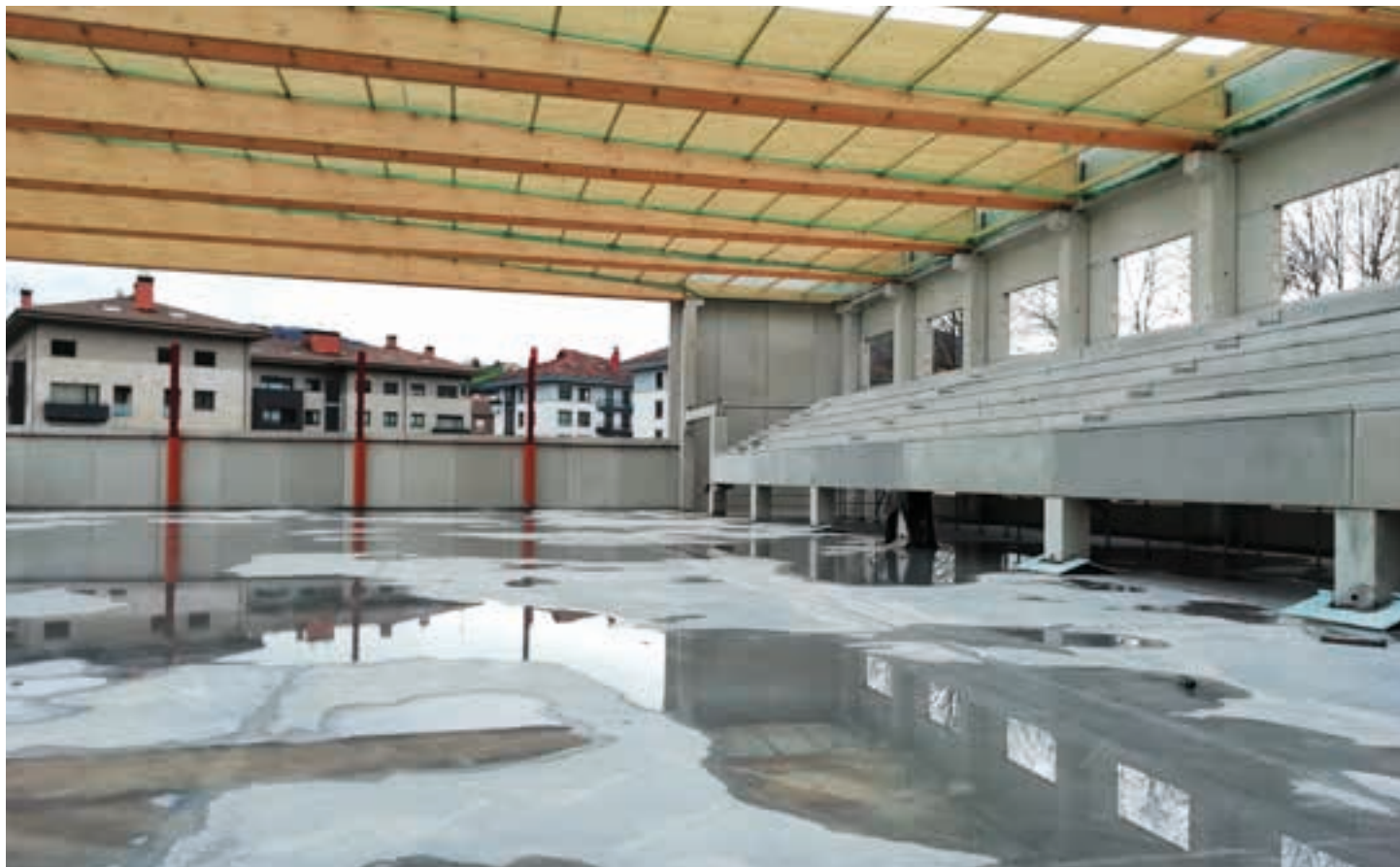
Laura Asensio Udal arkitekto teknikoak lanen egoeraren berri eman dio Aiurriri: "Egitura osoa ia-ia bukatuta dago. Orain estalkia jartzea falta da, baina horren egitura ere ia-ia bukatuta dago. Eskailerekin hasi gara, beheko solairuan, eta hasierako instalakuntzekin. Gero instalazioaren zatiketak egingo dira, eta eraikina itxi". URNIETAKO UDALA
