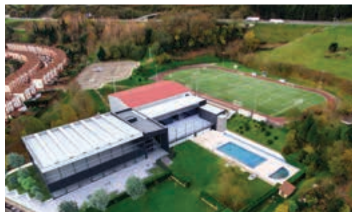
Kiroldegi berriaren instalakuntzaren irudi muntaia. UDALA
