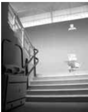
Ezinduei pilotalekuko sarrera ahalbidetzeko, plataformadun igogailua jarri da.
